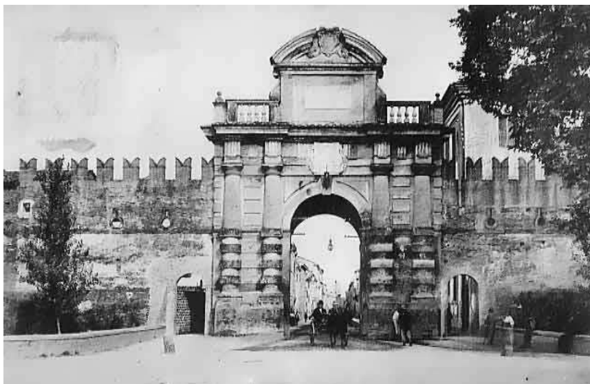
Faenza. Porta Imolese (demolida)
