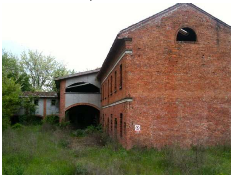
El molino Partitori en completo estado de abandono
