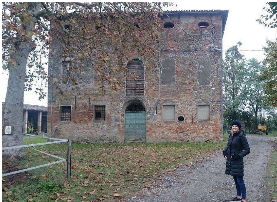
Pieve Cesato. Bajo esta añeja edificación, construida en el año 1500, yacen los cimientos de la Castellina, el lugar donde Alberigo Manfredi cometió la masacre inmortalizada por el Dante
