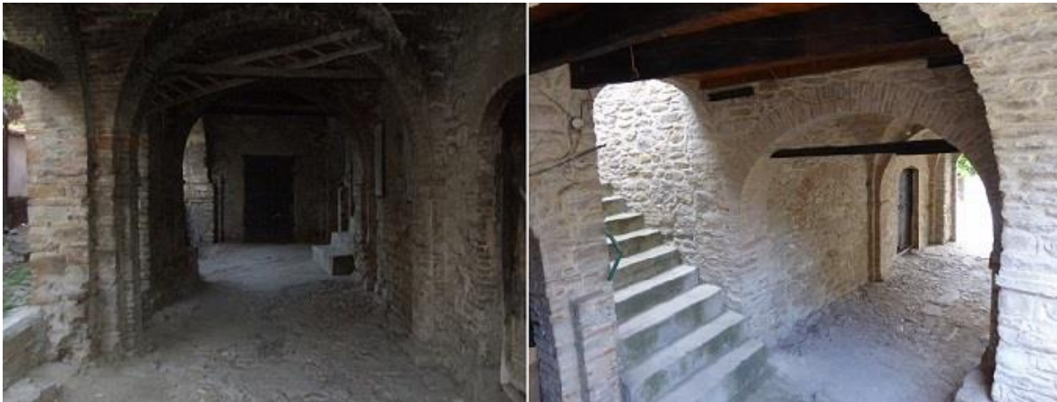
Dos vistas de la galería o corredor. A la izquierda, pasando la escalinata que lleva a la azotea, la puerta de acceso a la vivienda
