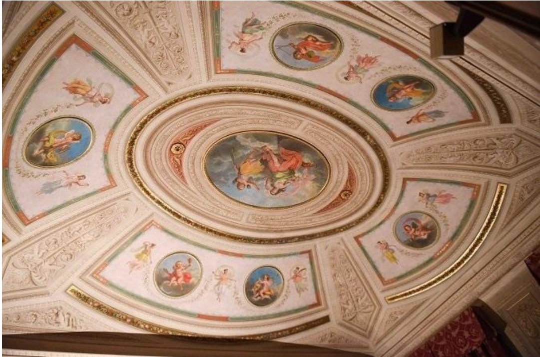
Palacio Belloni. Techos
